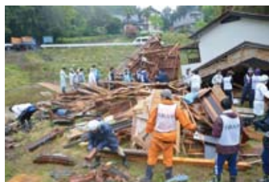
気仙沼市での流された家屋の撤去作業
