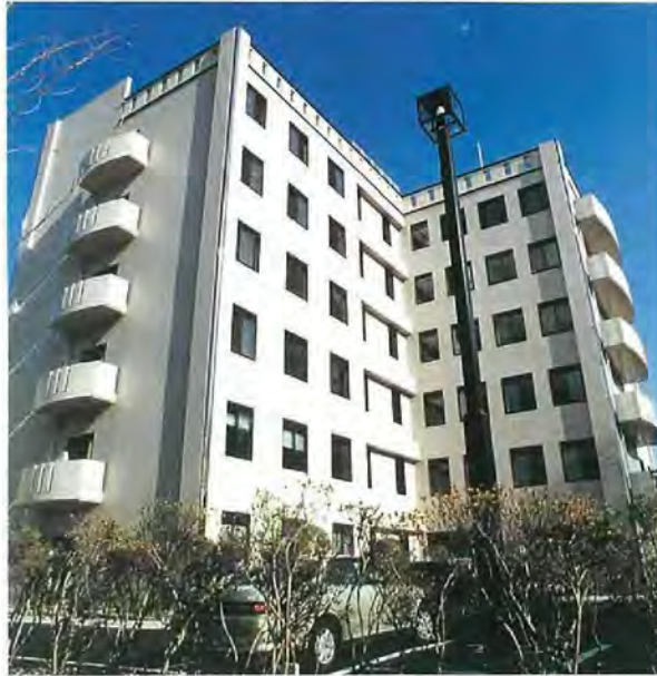
新校舎の南西面と駐車場
