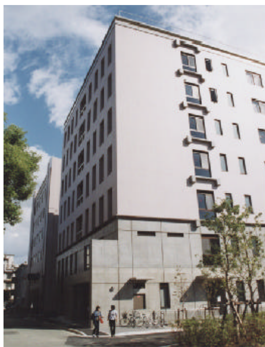
OSIPP棟の西隣 空中渡り廊下で連結
